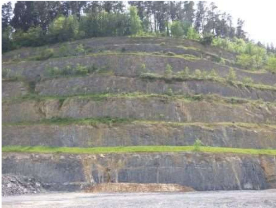
Foto general. Restauración
