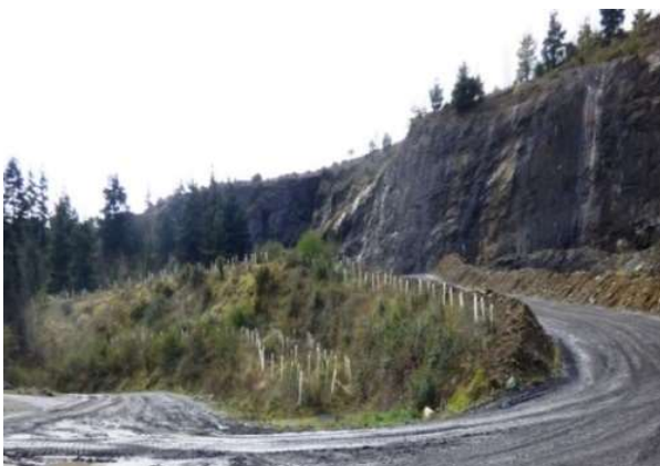
Estado restauración, año 2017
