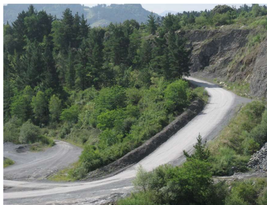
Estado restauración, año 2023
